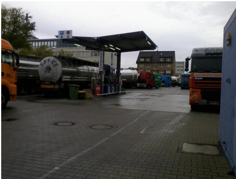
(Blick auf die Tankanlage von der Straße aus)
